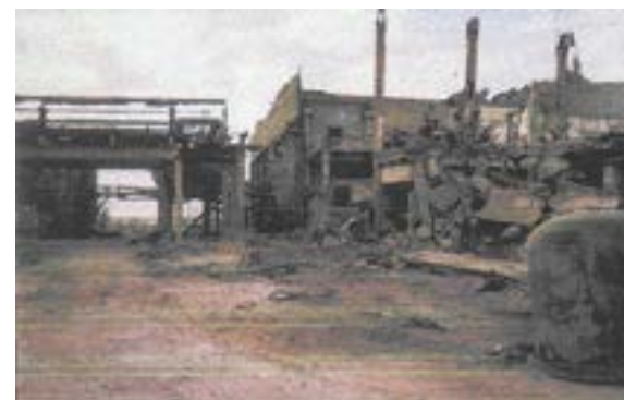
Рисунок 1 – Конструкции корпуса № 31 после остановки производства
